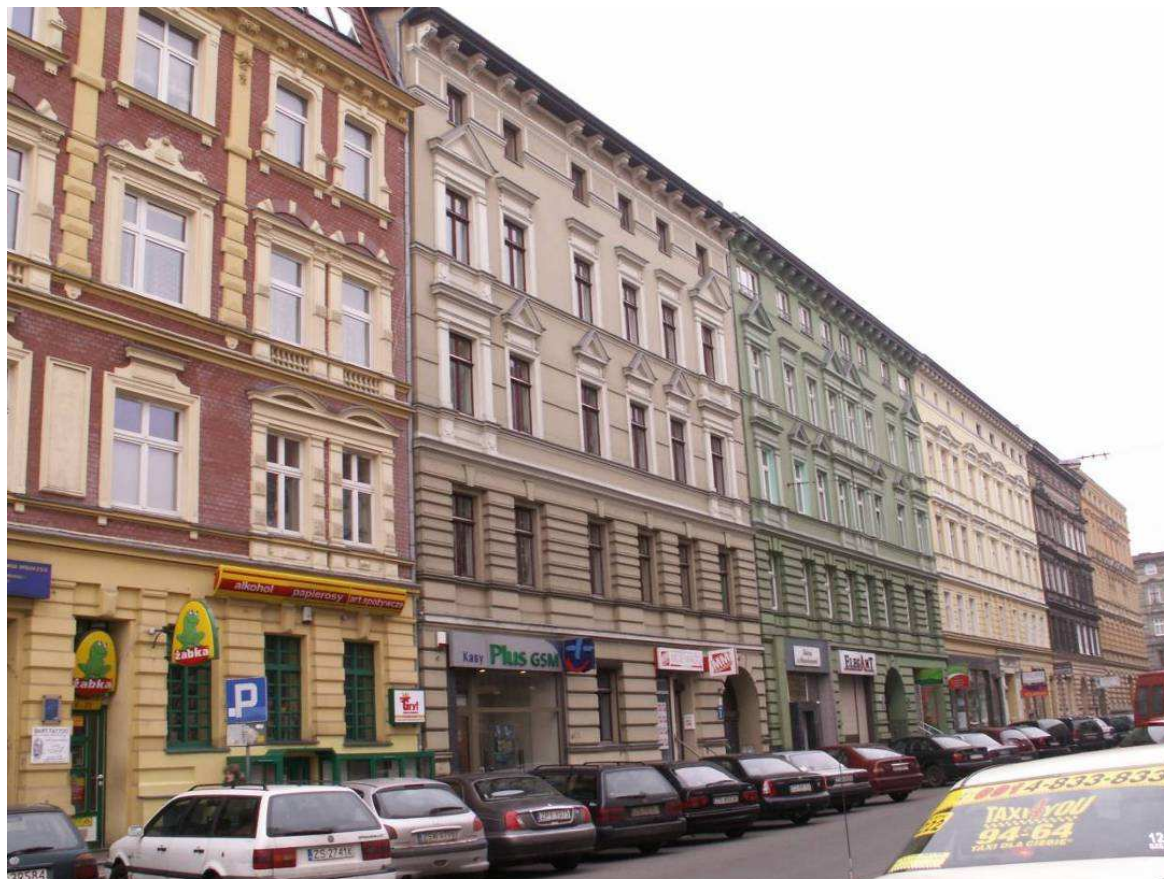
Abbildung 19. Von STBS sanierte Fronthäuser im Quartier 36
